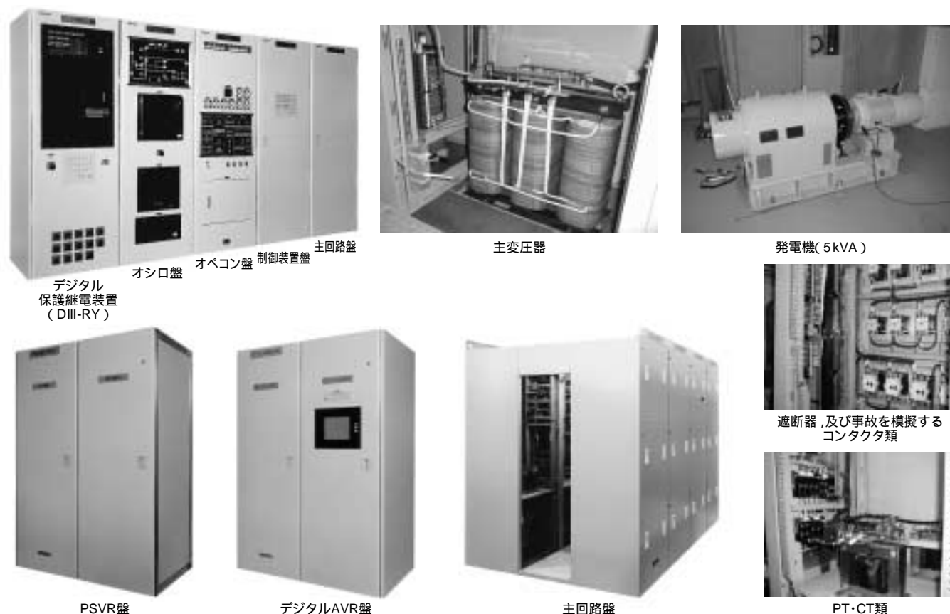
図3. 模擬発電系統設備の概観 発電制御訓練に使用される模擬設備全体を示す。 Simulation power generation system equipment
