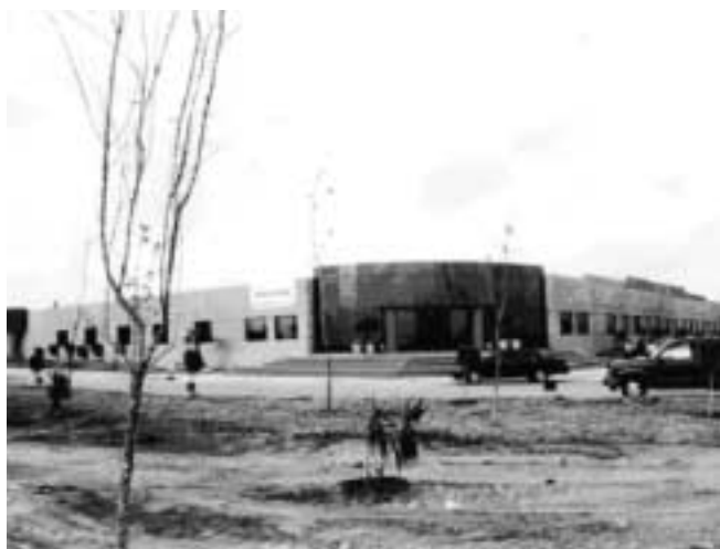
(a) GTTC社 メキシコ工場
