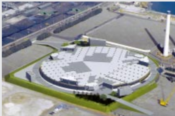
東京電力(株)新豊洲変電所全景 Overview of Shin-Toyosu Substation of The Tokyo Electric Power Co., Inc
