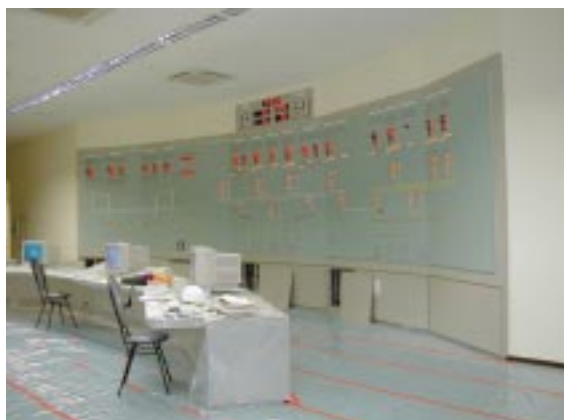
水力発電所向けマイコン分散監視制御システム Distributed information and control system for hydroelectric power plant
