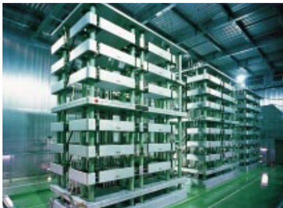
紀伊水道直流連系設備向けサイリスタバルブ Thyristor valve for Kii Channel HVDC transmission system
