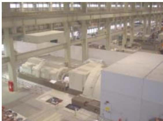
パワートレイン全景 Combined-cycle power train
