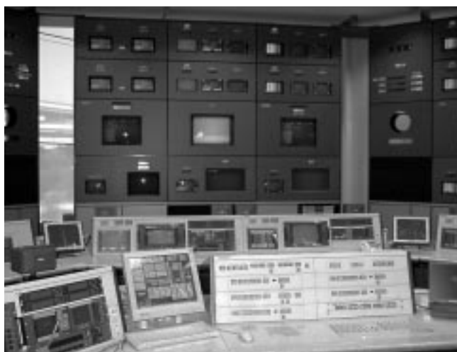
図4 . BSデジタル放送の監視卓とモニタ棚 複数番組送出の監視、操作が容易に行えるようになっている。
