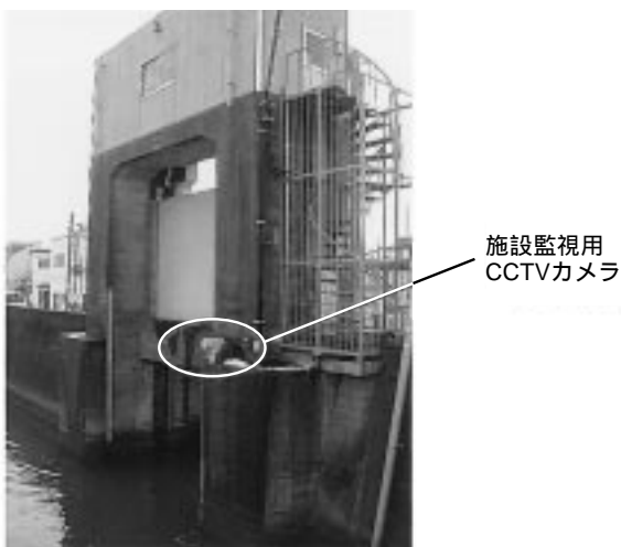
図1 遠隔監視・制御対象の例 河川管理施設の水門や施設監視用CCTVカメラを遠隔監視・制御している。 Example of remote supervisory control
