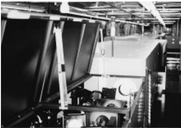
図4 .CVL-MOPA 1台の発振器と4台の増幅器が直列に配置され、高出力を達成している。 Copper vapor laser MOPA system
