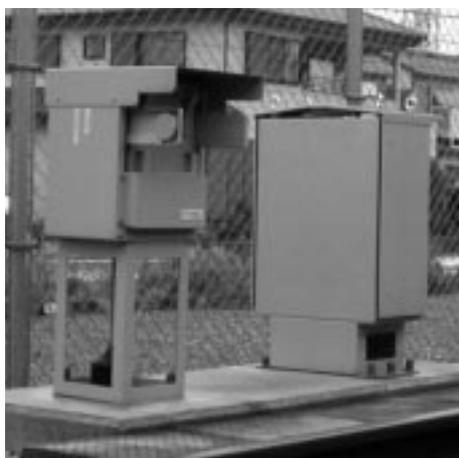
図3. 地上ビーコン 車両が必ず通る入出庫線近傍に設置され, 車上ビーコンと交信する。この装置は, 光LANで地上モニタ情報管理システムに接続されている。
