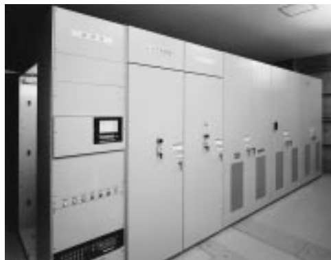
図5 . 650 kW変電所向け実証用NAS電池電力貯蔵用PCS 変電所設置用として高効率化を図った。
