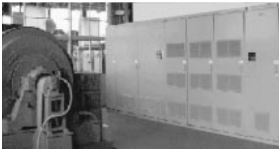
図9．実稼働中の省エネドライブ装置 99年8月から実運転中の省エネドライブ装置である。 Energy-saving drive system in operation
