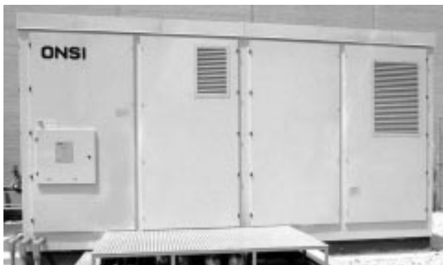
図8．燃料電池の外観(コンカー処理場) 世界初の消化ガス燃料電池発電システムである。
