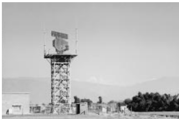
図2 .トリブバン国際空港ASR局舎 アンテナは毎分15回転する。上部はSSRアンテナ。レーダ情報は光ケーブルで局舎からレーダ管制所に送られる。
