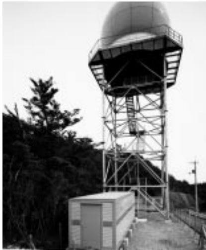
図 2 . 可搬型 SSR 装置 鉄塔上部にアンテナが設置され、その近くに移動性を重視したシェルタ構造の装置(写真下)が設置される。 Movable type SSR system
