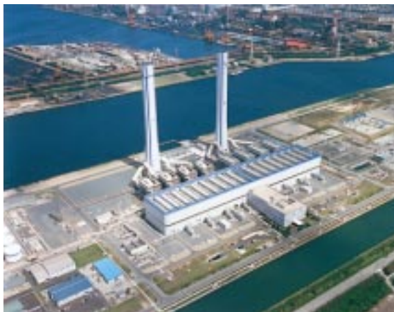
東京電力(株)千葉火力発電所全景 Overview of Chiba Thermal Power Station of The Tokyo Electric Power Co., Inc.
