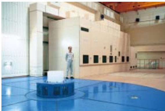
可変速発電電動機用GTO変換器 GTO inverter and converter for adjustable-speed generator-motor
