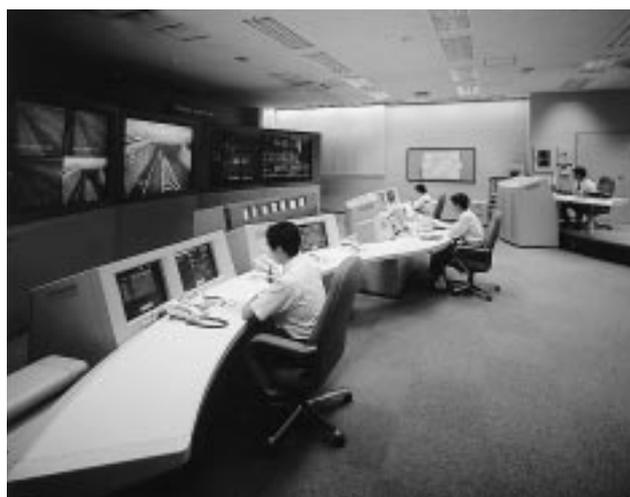
図4. 広域施設管制室 道路上の照明やトンネル換気設備など各種施設を監視し、故障管理をしている。
