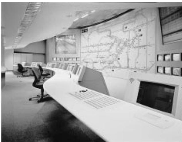
図3. 交通管制室 収集された情報をグラフィックパネルやCCTVモニタによって監視し、オペレータコンソールを用いて交通管制業務を行う。また、非常電話からの事故通報の対応を行う。
