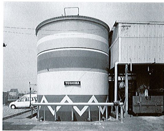
図1. メタン発酵バイオリアクタ 高濃度廃水を嫌気性微生物であるメタン菌で処理する省エネルギー装置である。
