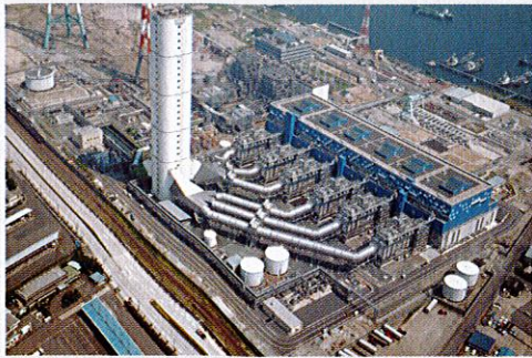
中部電力(株) 新名古屋7号系列全景 Overview of Shin-Nagoya Unit No. 7 of Chubu Electric Power Co., Inc.
