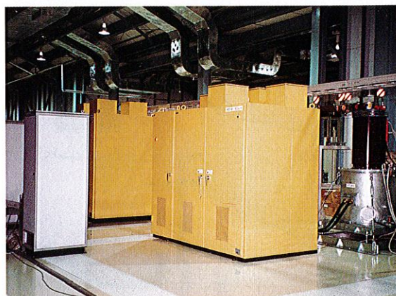
SPring-8 80 MW クライストロンモジュレータ装置 80 MW klystron modulator for SPring-8 linac
