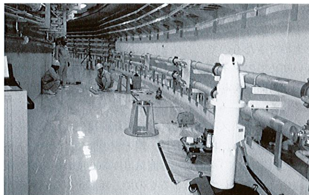
図 12. 精密アライメント 移動式三次元レーザトラッキングシステムを用いて、204 個の電磁石を 0.1 mm のオーダで精密据付けを行う。図は基準点を設定している様子を示す。
