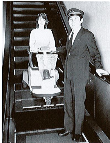
図1. 車いす利用状況 大型の電動車いすでもゆとりをもって利用できる。 View of wheelchair operation
