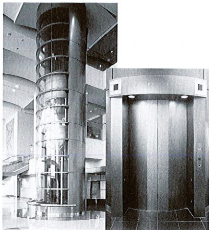
図6. 円形を基調としたエレベーターと円形ドア 扇形に開閉する円形ドアのぞん新なエレベーター。
