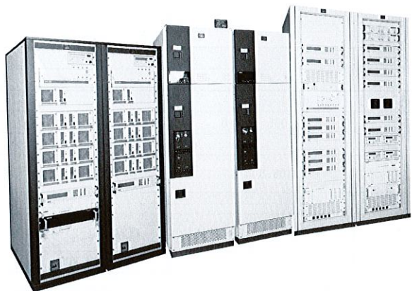
図4. 無線設備の一部 送信機, 周波数変換装置などを示す。
