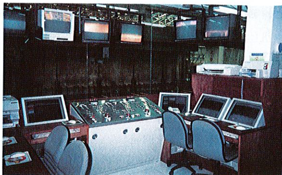
加熱炉プラント監視制御装置 OIS1000 OIS1000 human interface station for reheating furnace
