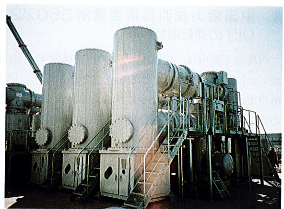
東京電力株千葉火力発電所300 kV GIS 300 kV GIS for Chiba Power Plant
