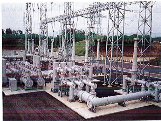
中国電力株西島根変電所 550 kV GIS 550 kV GIS for Nishi-Shimane Substation
