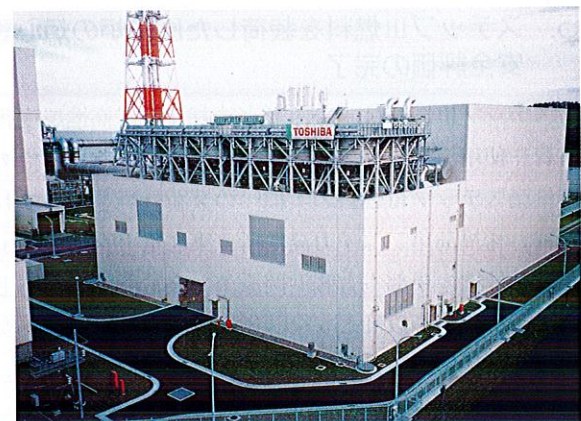
運用補助共用施設建屋(使用済燃料共用プール設備) Spent fuel storage pool building
