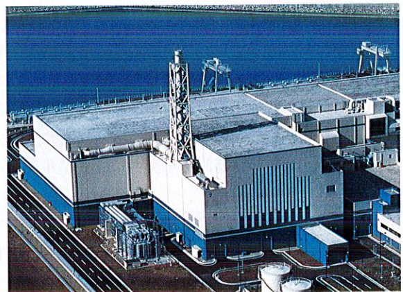
東京電力株柏崎刈羽原子力発電所7号機 Kashiwazaki-Kariwa Nuclear Power Station Unit No. 7
