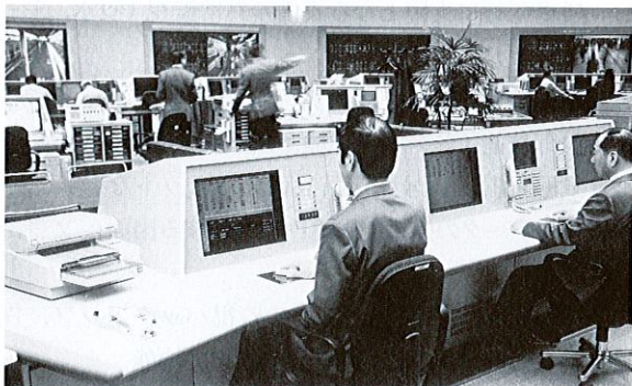
図2. 総合指令所における設備指令卓 設備の管理と現業部門の業務支援を行ない、安全な輸送の支援を行う。
