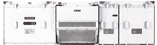
図5. IGBTインバータ装置 中央部がインバータユニット、その右側が制御部、CHSユニット、左側がトランス部で構成している。
