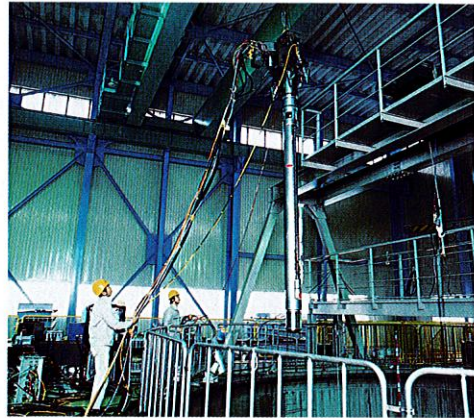
ショットピーニング施工用遠隔自動機の模擬原子炉への吊込み Remote handling equipment for shot peening in reactor core region
