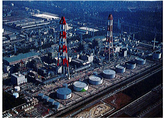
知多火力発電所(1~6号ユニット)の全景 Overview of Chita Thermal Power Station (Units No. 1-6)
