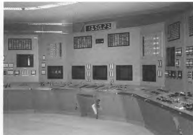
図2. 女川2号機の中央制御盤 1号機と共に用の中央制御室に調和性、操作性を考慮した最新機能の盤を採用した。
