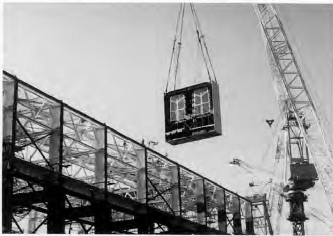
図5. 復水器下部本体の吊込み 重量80tのブロックに四分割して現地搬入した。
