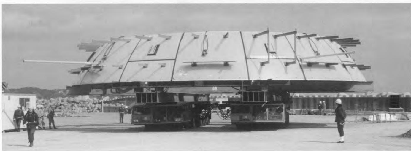
図4. 原子炉格納容器(PCV)の大リングブロック運搬 PCV 円筒部の工場組立、現地搬入により工事効率を向上させた。原子炉格納容器の大リングブロック運搬状況を示す。
