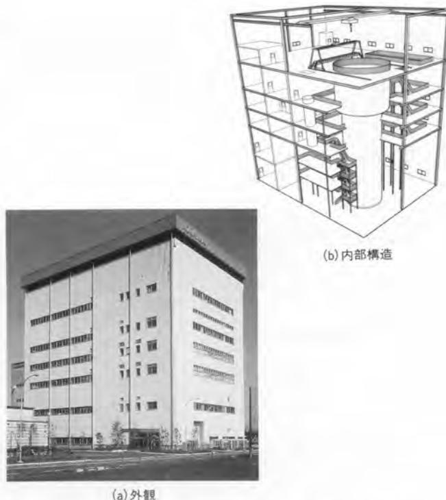
図3. プラントリフレッシュ技術開発設備 炉内構造物の取替えなど、経年プラントのリフレッシュ技術を含めた保全に関する技術開発や作業訓練を行う。
