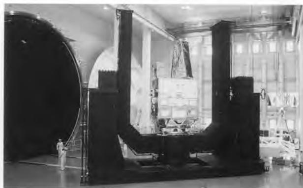
図5. STM 熱試験の状況 静止ソーラ熱平衡試験において，STMをスペースチャンバ内に収納するようすを示す。アンテナは搭載しない。
