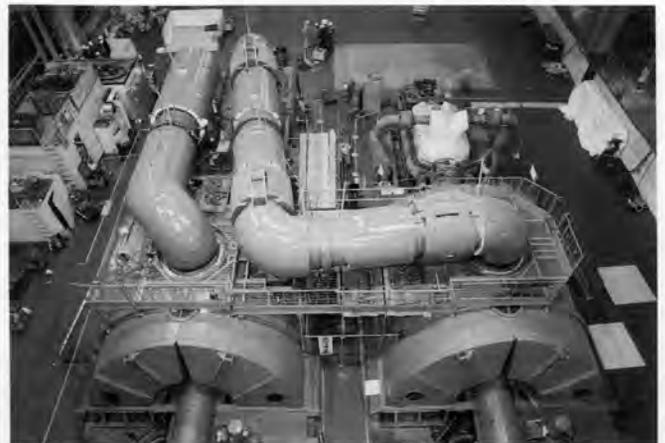
図3. 専用架台によるクロスオーバー管の分解組立工事 600 MW級のクロスコンパウンド機で専用架台を利用してクロスオーバー管の分解・組立工事を行う。
