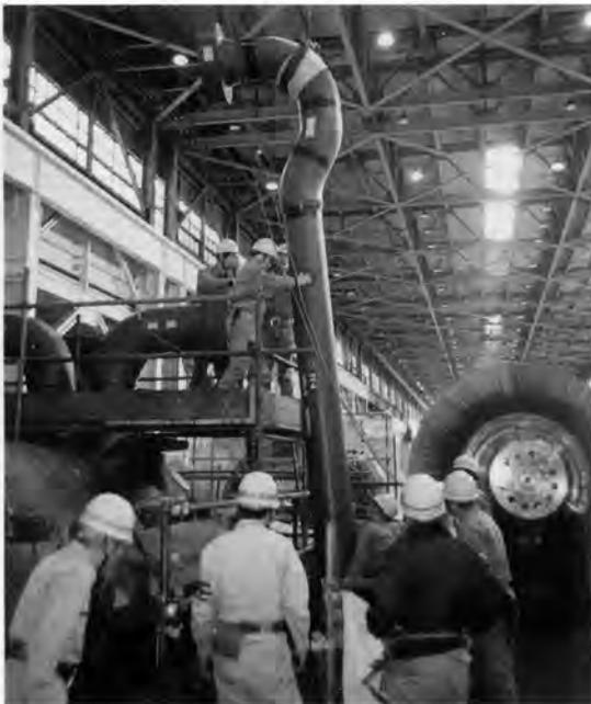
図2. リード管つり込み作業 工場で一体化溶接を行ったリード管のつり込み作業を行っている。
