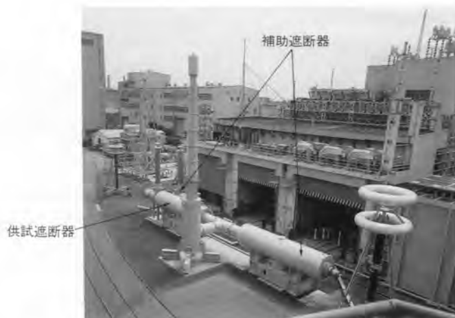
図 20. 1,000kV ガス遮断器の脱調全点遮断試験 世界初の大規模な抵抗遮断部の脱調全点遮断試験を実施した。
