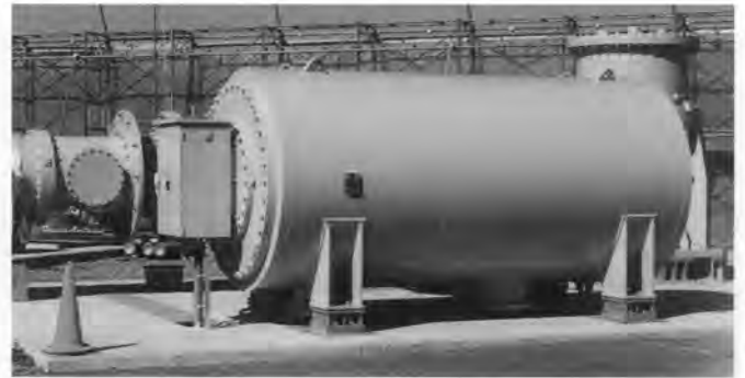
図 12. 1,000kV 避雷器 (線路引込み口用) ブッシングの絶縁に影響を与えないように横型にした。
