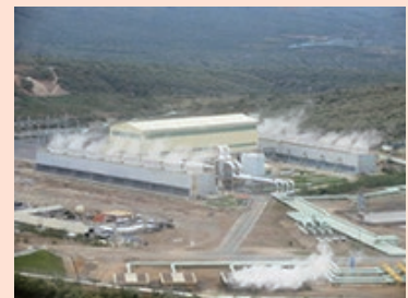
ケニア・オルカリア4号地熱発電所
