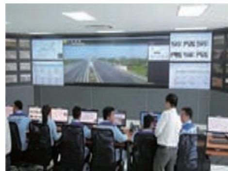
高度道路交通システムの運用が開始されたベトナムの高速道路交通管制センター
