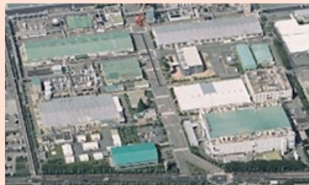
クリーンルームの省エネに取り組む 姫路半導体工場
