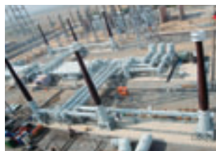
超々高圧(1,100KV)送变电プラント 高い送電効率で送電ロスを低減でき、大容量の電力と長距離の送電に貢献
