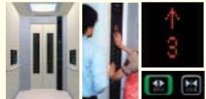
インジケーター表示点灯色は、より多くの人が認識できるオレンジ色。操作ボタンは、役割によって形状を変え、より大きく押しやすくしました。車イスの方や目の不自由な方にも配慮しています。
