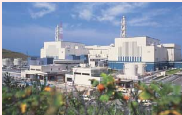
柏崎刈羽原子力発電所
