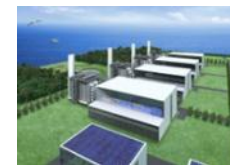
水素ガスタービン
