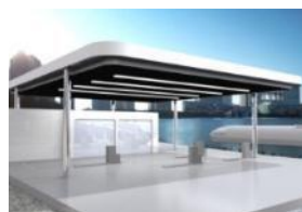
水素供給施設
