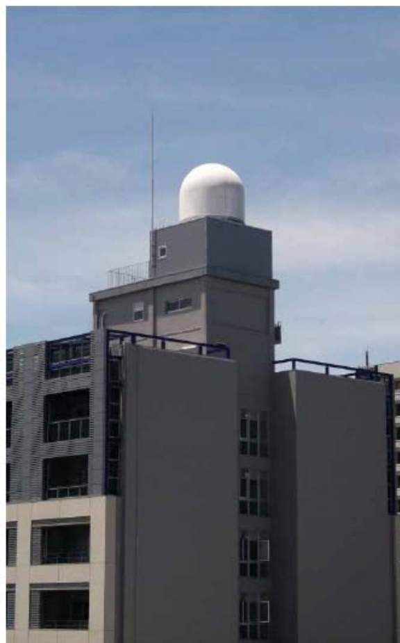
大阪大学に設置されたフェーズドアレイレーダ
