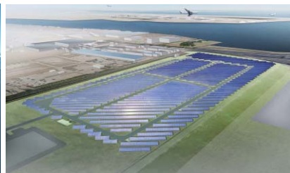
東京電力様 浮島太陽光発電所
