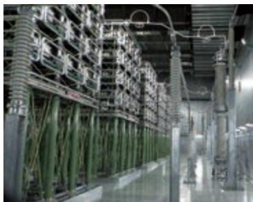
運転を開始した新北海道本州間連系設備(交直変換設備)
