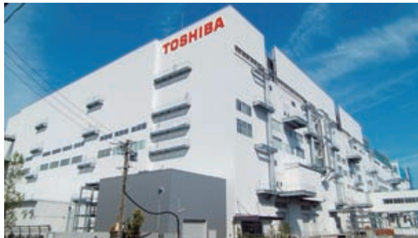
3次元フラッシュメモリを生産する四日市工場の新しい第2製造棟
