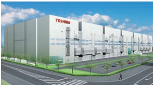
最先端製品量産予定の四日市工場第5製造棟(完成イメージ)
