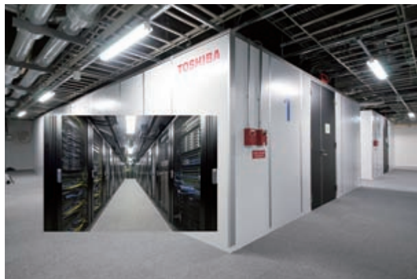
記憶装置が設置されている屋内モジュール型データセンター(イメージ)
