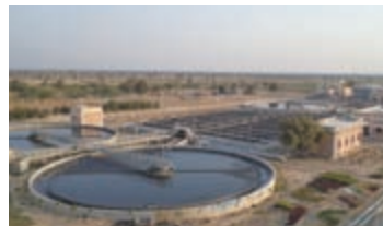
インドで運用されている下水処理プラント
