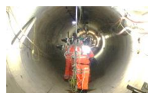
トンネル検査
