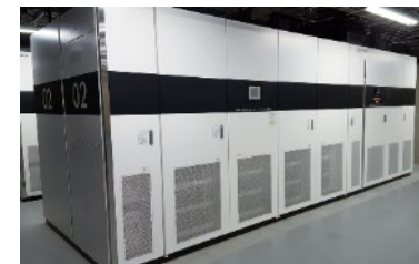
受変電システム (UPS)
