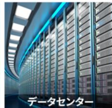
データセンター
