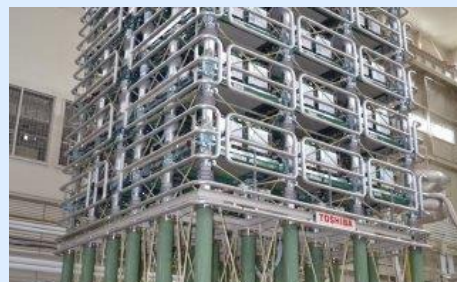
HVDC向け(直流送電)変換器
