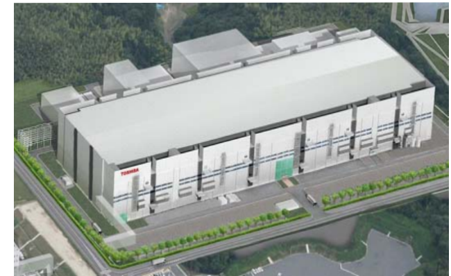
四日市工場 第5製造棟
