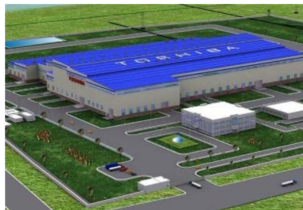
インド火力発電設備新工場(2011年1月稼動予定)
