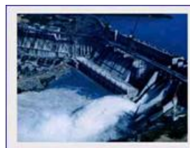
水力発電設備
