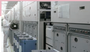
東芝四日市工場 第四製造棟
